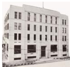
竣工当時の人絹会館
