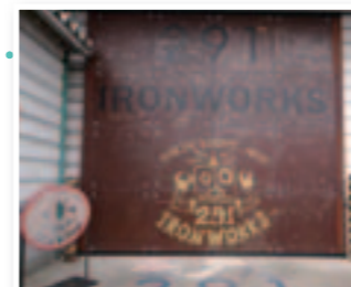
同社工場にある鉄製の扉。錆の風合いが楽しめる「ラスト加工」が施されている。
