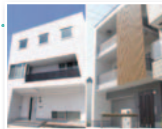
こだわりのデザインと構造に配慮した同社目玉の重量鉄骨3階建住宅。
