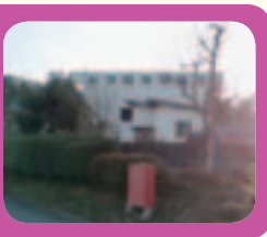
道路から見た社屋(社名文字と消火栓が目印です)
