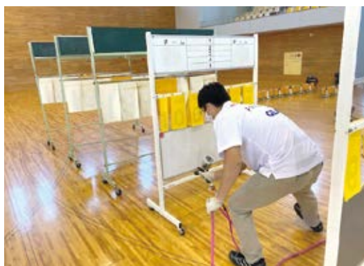
光触媒コーティングの施工風景写真
